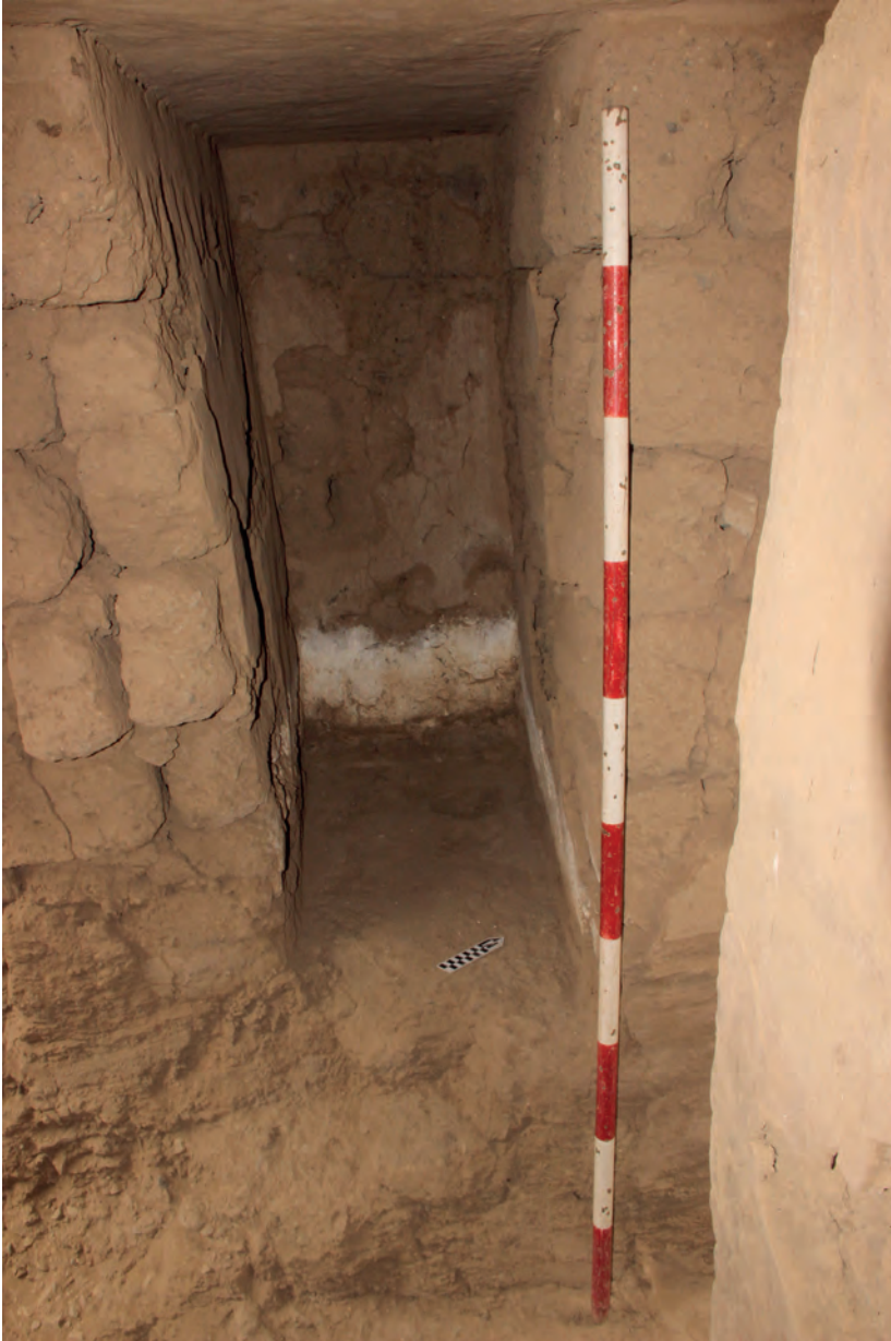
Figura 5. Vista de una de las hornacinas de la cámara 01. Nótese los restos de pintura blanca en la base de la hornacina.
